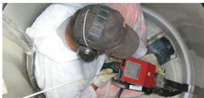
Nach dem Einsetzen der Elemente und dem Setzen der mit elektrischer Hochspannung geprüften Schweißnähte werden die Hohlräume mit einem speziellen frühfesten Dämmmaterial aus dem Hause Schacht+Trumme® verfüllt. Durch die für das Material charakteristischen Ankernoppen entsteht so eine absolut feste Verbindung mit dem Schacht.
